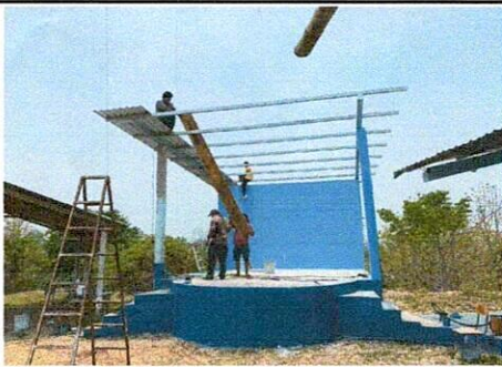
SUSTITUCION DE LAMINA, POR LAMINA TROQUELADA ALUZINC CALIBRE 26
