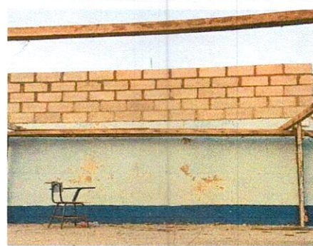
REPARACIÓN DE MURO
