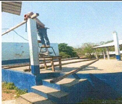
REPELLO EN MURO
