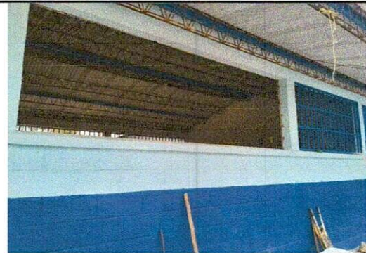
SUSTITUCIÓN DE BALCONES
