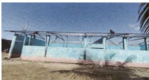
Foto 3: Sustrucción de capote de lámina para lámina troquelada
