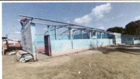
Foto1: Sustrucción de lámina, por lámina troquelada aluzinc calibre 26 modulo de aulas y direccion
