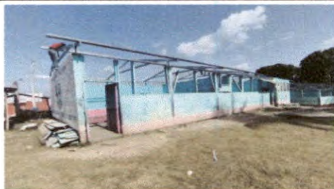
Foto1: Sustrucción de lamina, por lamina troquelada aluzinc calibre 26 modulo de aulas y direccion
