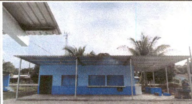
Foto1: Se realizo levantado de pared, cambio de lamina, instalacion de puertas y ventanas, intalacion de energia electrica, pintura en la parte externa de la cocina y construccion de piso de concreto.
