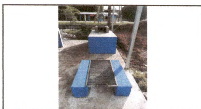
Foto 6: construccion de polleton con sus respectivas parrillas.
