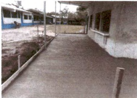
Foto 7: se esta realizando la preparación del piso de concreto en el area externa de la cocina.
