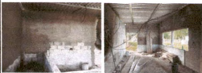
Foto 8: Se esta realizando el repello y cernido en las paredes en la parte interna y externa de la cocina.
