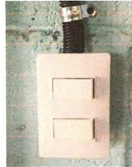
Foto 8: Sustitución interruptores dobles
