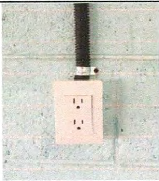
Foto 9: Sustitución tomacorrientes dobles
