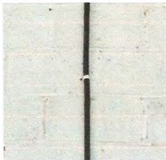
Foto 11: Reparación de cableado eléctrico
