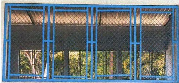
Foto 6: Mantenimiento a balcones de metal
