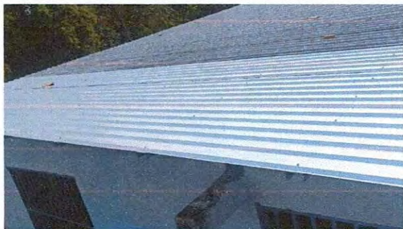
Foto1: Sustrucción de lámina, por lámina troquelada calibre 26.
