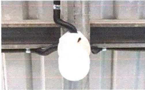
Foto 7: Sustitución de plafoneras
