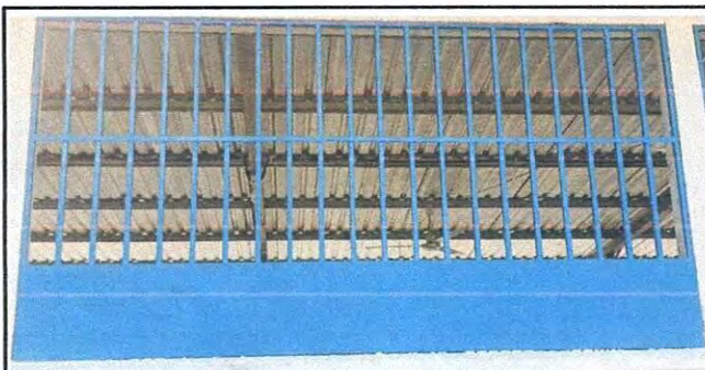
Foto 3: Sustrucción de ventanas de madera por metal más vidrio
