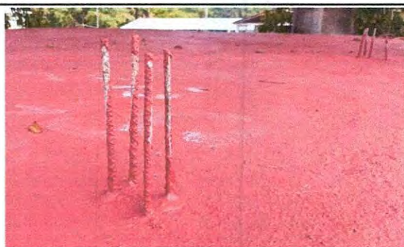
Foto 4: Impermeabilización de losa.
