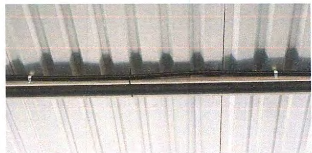
Foto 12: Sustitución de ducto eléctrico + accesorios
