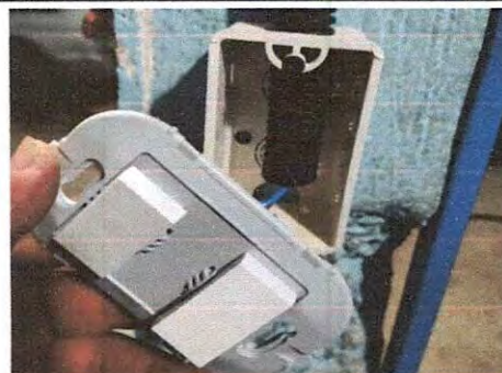
Foto 8: Sustitución interruptores dobles
