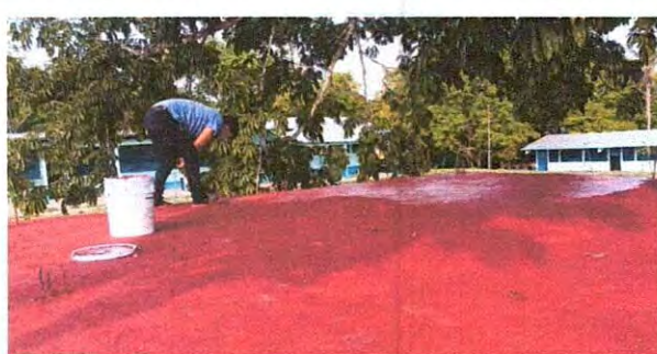
Foto 4: Impermeabilización de losa.
