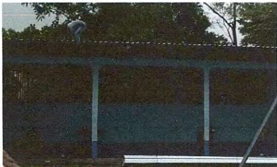
Foto 1: Sustitución de lámina, por lámina troquelada calibre 26.
