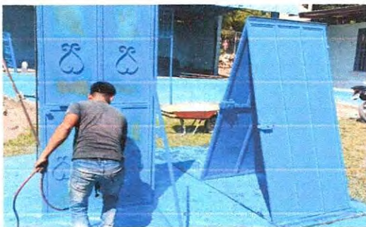
Foto 5: Mantenimiento a estructura (lijado, cepillado y aplicación de pintura de puertas)
