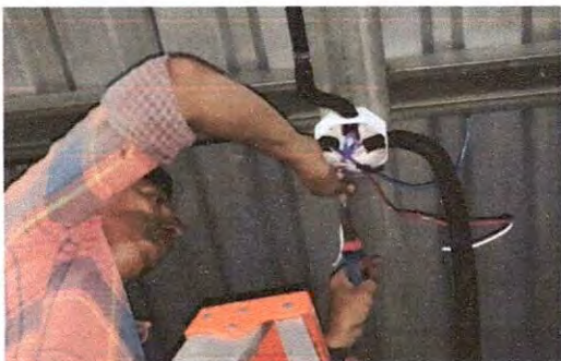
Foto7: Sustitución de plafoneras
