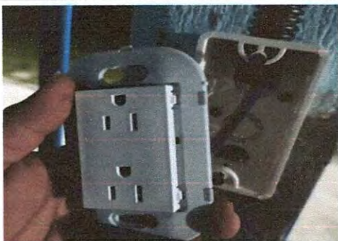
Foto 9: Sustitución tomacorrientes dobles
