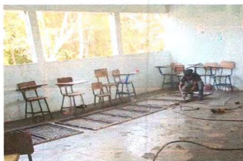
Foto 6: Mantenimiento a balcones de metal
