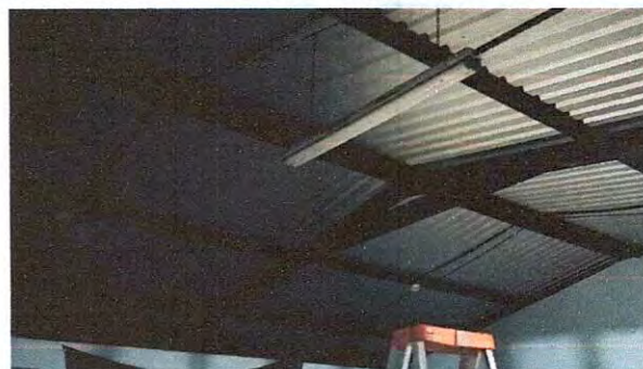
Foto 10: Sustitución de lámparas de 2x40
