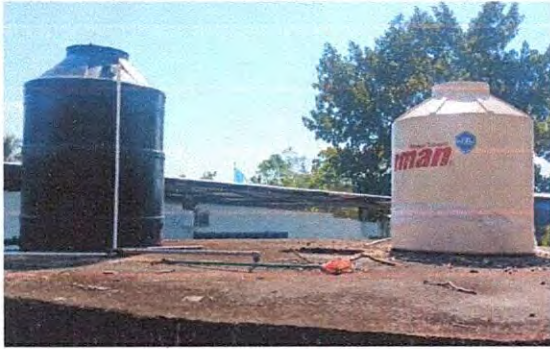
Foto13: Sustrución de deposito de agua 1700 lt
