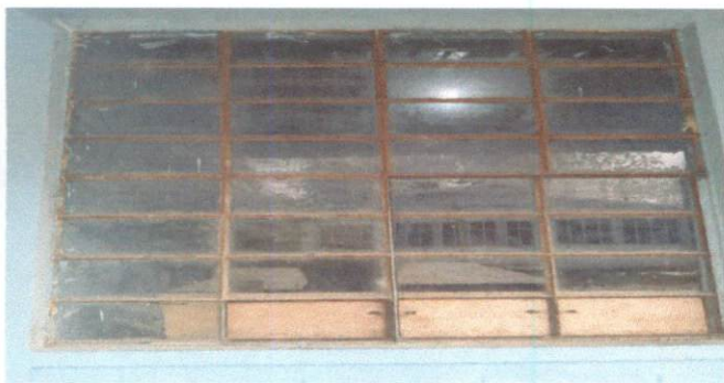
Foto1: Antes de la instalación de balcones de la dirección
