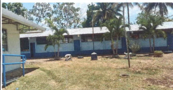
Foto1: Antes de iniciar el trabajo de pintura de exterior e interior de la escuela.
