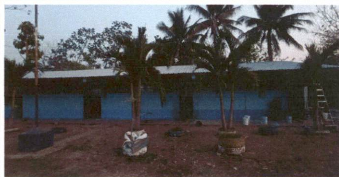
Foto 2: Durante el trabajo de pintura de exterior e interior de la escuela.
