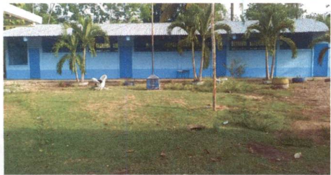
Foto 3: Despues del trabajo de pintura de exterior e interior de la escuela.
