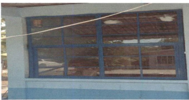
Foto 3: Despues de la instalación de balcones de la dirección.
