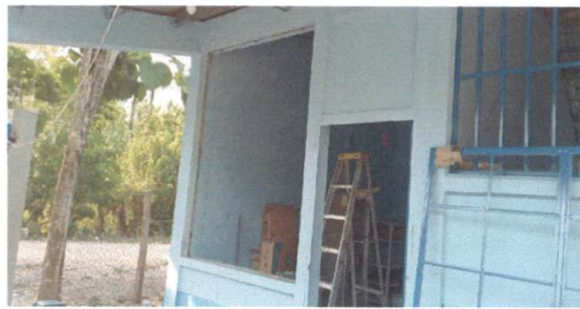
Foto 2: Durante la instalación de balcones de la dirección.
