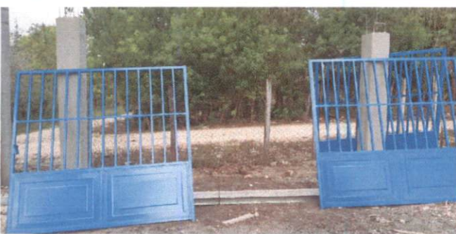
Foto 2: Durante la instalación de portones y muros de concreto,
