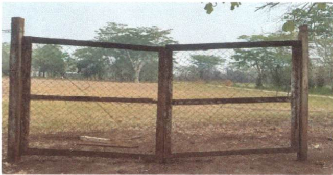
Foto 1: Antess de la instalación portones y muros de concreto..
