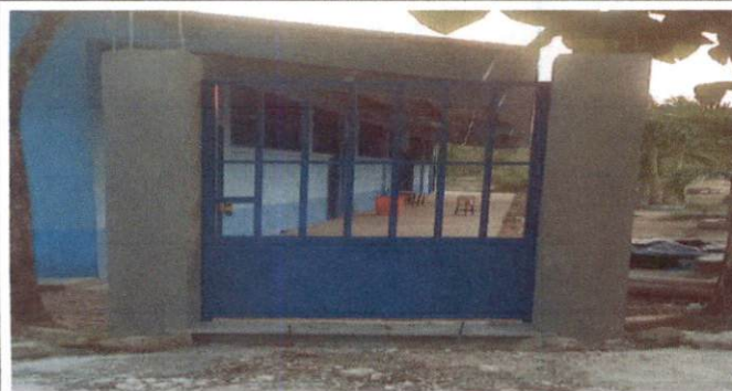
Foto 3: Despues de la instalación de portones
