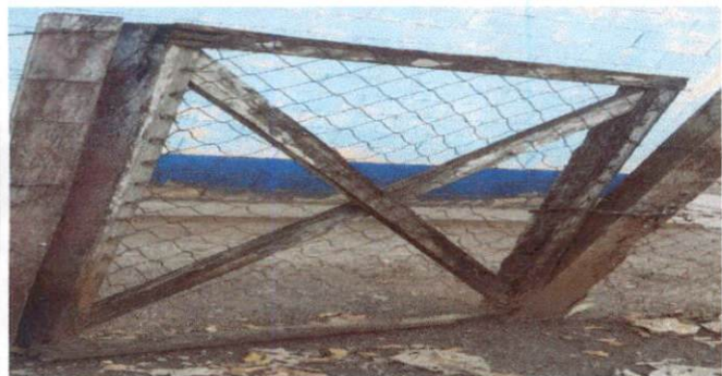
Foto1: Antes de la instalación de portones y muros de concreto.
