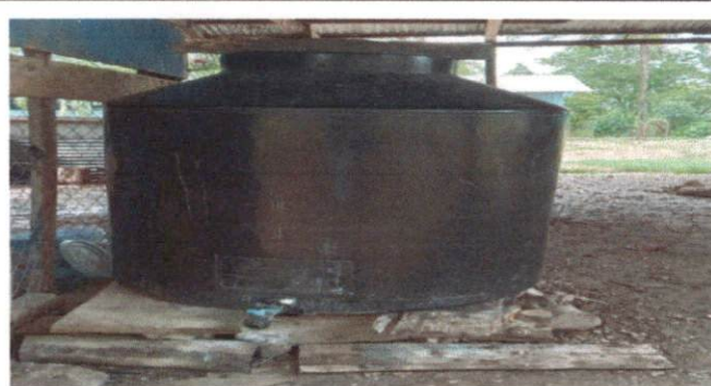
Foto 1: Antes de instalación de tubería y deposito del agua.
