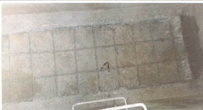
Foto 3: Despues de la limpieza de fosa septica.
