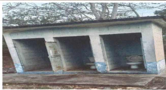
Foto 1: Antes de comenzar el trabajo de pintura.
