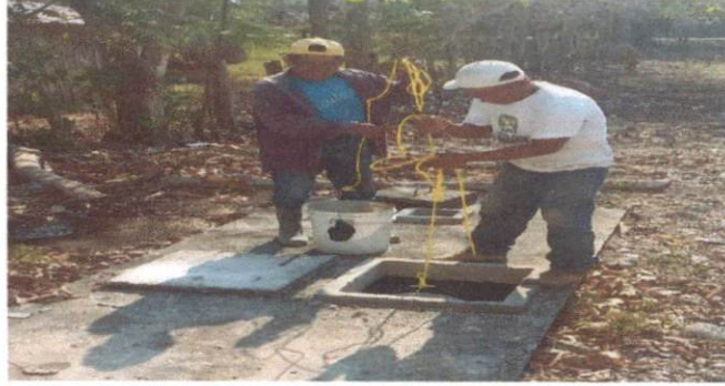
Foto 2: Despues la limpieza de fosa septica.
