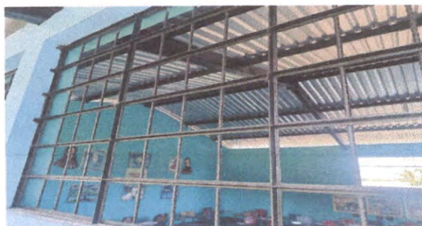
Mantenimiento a balcones de metal.
