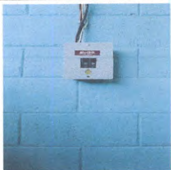
Sustitución de tablero y flipon.
