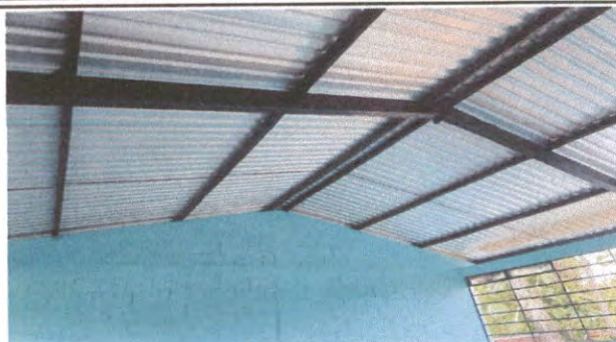
Mantenimiento de estructura de soporte de metal.
