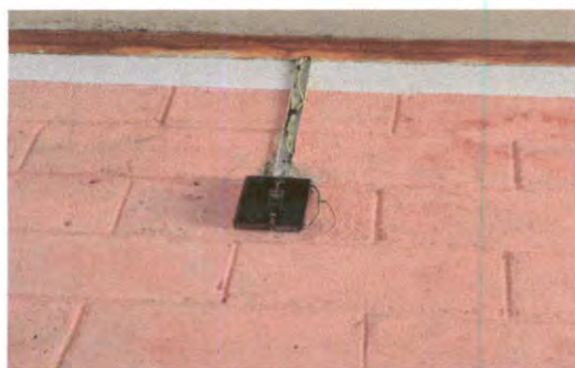
Sustitución de tablero y flipon.
