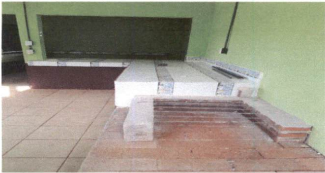
sustitucion de piso ceramico
