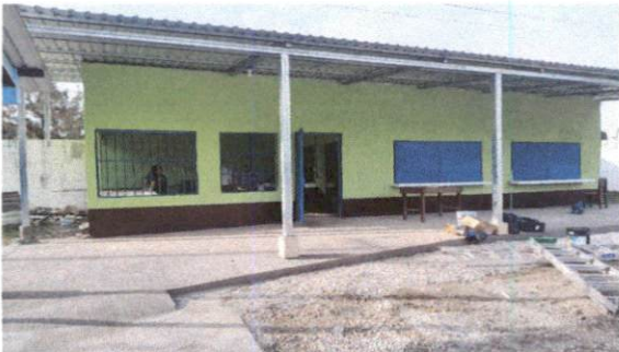
sustitución de torta de cemento
