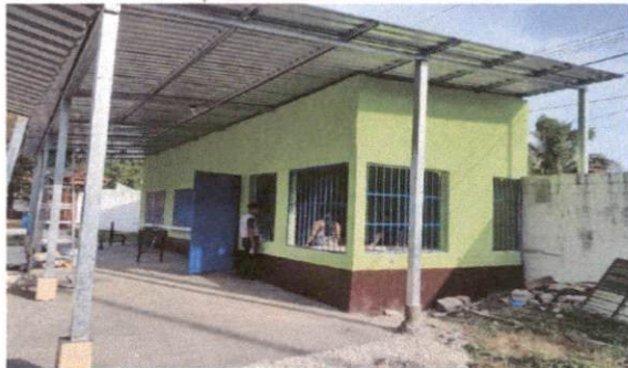
sustitucion de lamina por lamina troquelada alisic calibre 26
