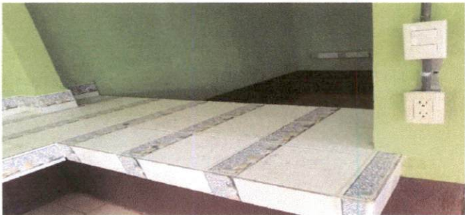
mantenimiento a estufa rural
