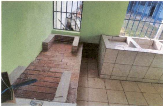
sustitucion de piso ceramico
