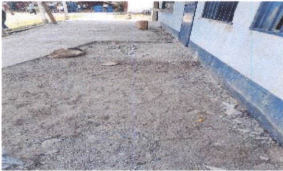
sustitución de torta de cemento
