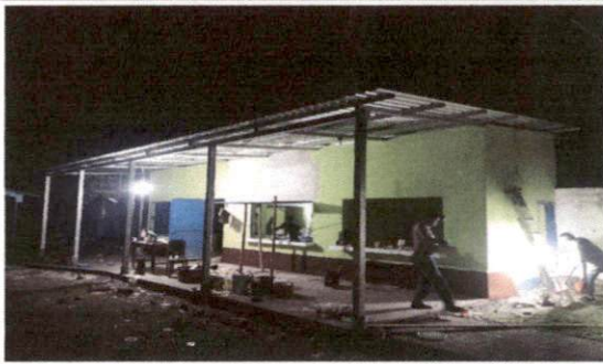
sustitucion de lamina por lamina troquelada alisic calibre 26
