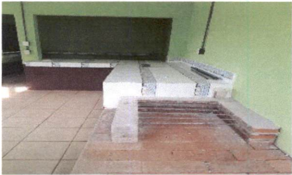
mantenimiento a estufa rural
