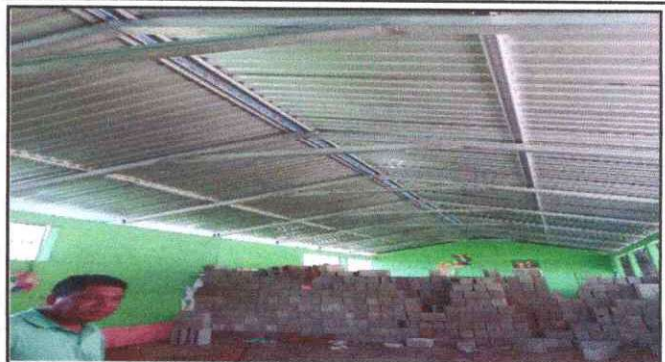
Foto 2: 2.2 susutitucion de estructura de soporte madera por metal M2
