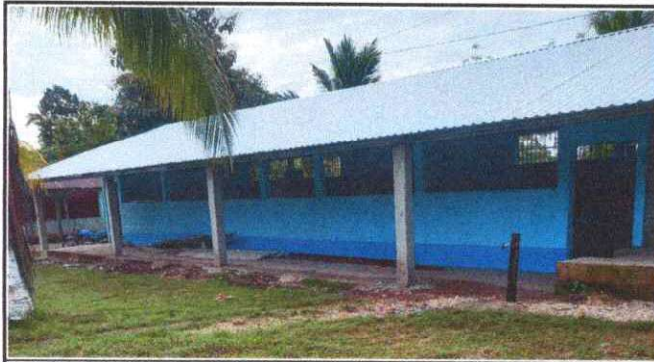
Foto1: .1 Sustitucion de lamina por lamina alucyn calibre 26 m2
