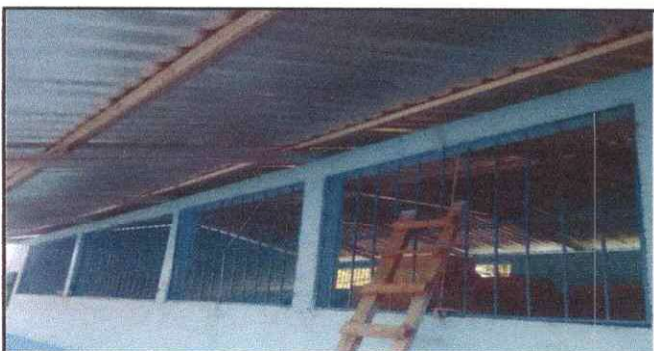
Foto 5: 11.1 Fabricacion e instalacion de ventana balcon de metal 5.7
