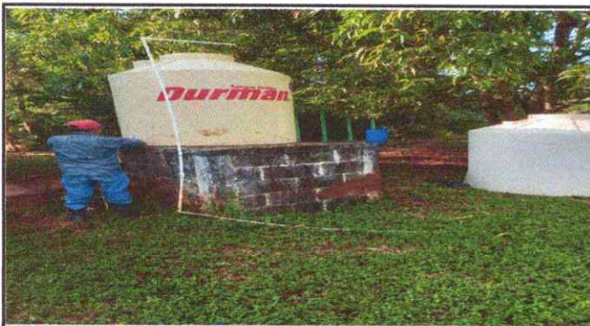
Foto 3: 18,1sustitucion de deposito de agua 1000 lt unidad
