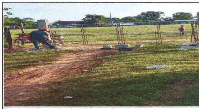
Foto 6: 15.3 Reparacion de tubo hg y malla galvanizada
