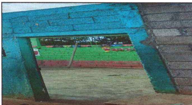
Foto 4: 4.3 sustitucion puerta de metal unidad
