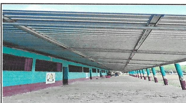
Foto 4: Instalación de la estructura metálica del corredor de 5 aulas una bodega y una dirección
