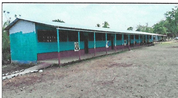
Foto 3: Cambio total de elementos de fijación de lamina de 5 aulas una bodega y una dirección
