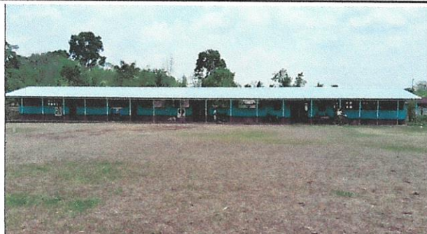
Foto1: Cambio total de cubierta de 5 aulas una bodega y una dirección
