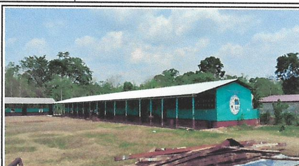
Foto 2: Cambio total de estructura metálica en 5 aulas una bodega y una dirección
