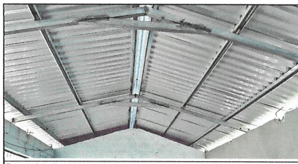
Foto 5: Interior de las aulas con la nueva cubierta de estructura metálica y lamina troquelada
