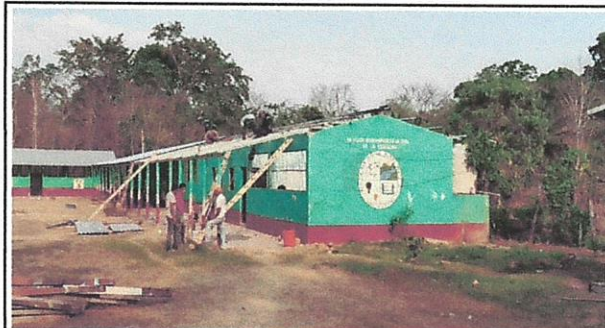
Foto 2: Montaje total de estructura metalica de 5 aulas una bodega y una dirección
