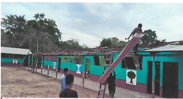
Foto 6: Desmontaje de estructura de madera del corredor de 5 aulas una bodega y una dirección
