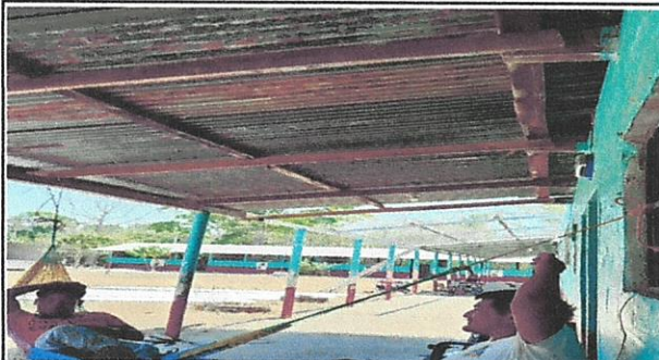
Foto 3: Montaje total del techo del corredor de 5 aulas una bodega y una dirección
