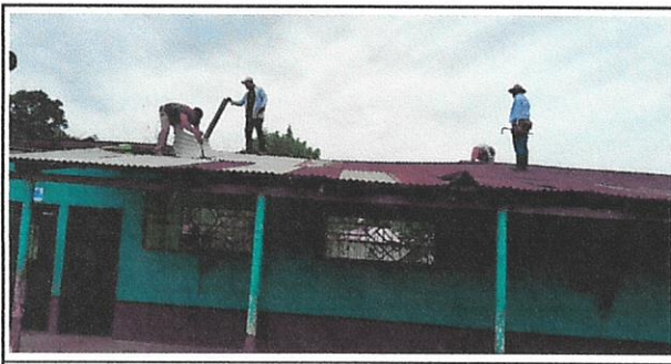
Foto 5: Desmontaje de la cubierta de lamina de 5 aulas una bodega y una dirección
