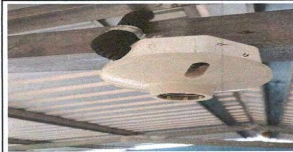
Foto 6: Sustrucción de plafoneras
