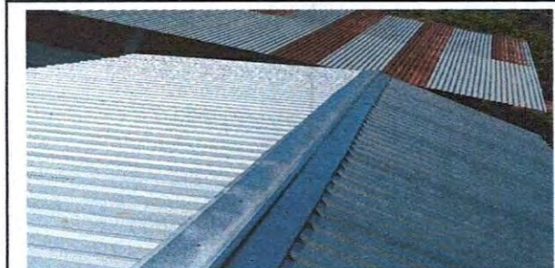
Foto 12: Sustrucción de lámina, por lámina troquelada aluzinc calibre 26
