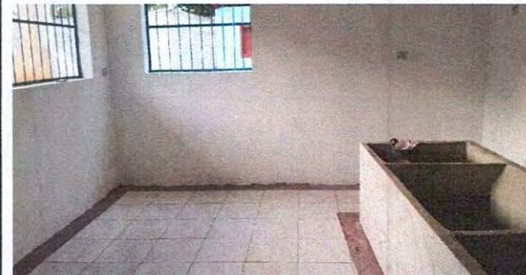
Foto 14: Reparación de piso cerámico
