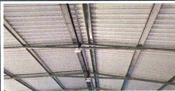
Foto 5: Sustrucción de focos ahorradores
