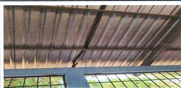
Foto 11: Reparación de cableado eléctrico
