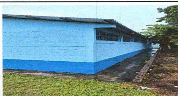
Foto 3: Pintura en muros exteriores e interiores
