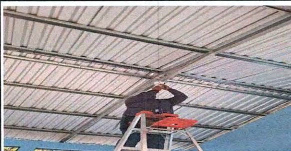
Foto 5: Sustrucción de focos ahorradores
