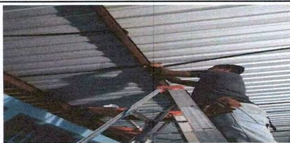
Foto 11: Reparación de cableado eléctrico
