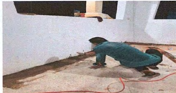
Foto 14: Reparación de piso cerámico
