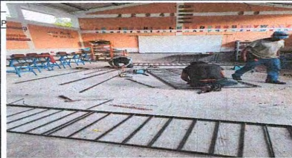
Foto 2: Sustrucción de balcones de metal
