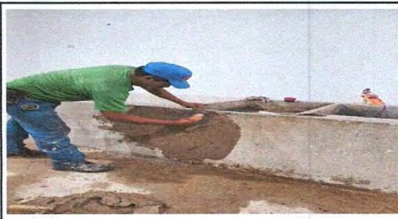
Foto 4: Sustrucción de pila de cemento de un lavadero
