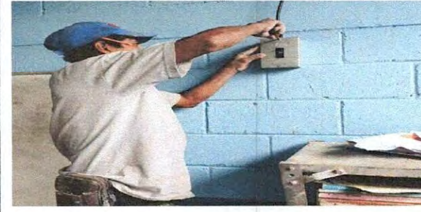
Foto 10: Sustitución de tablero de flipones
