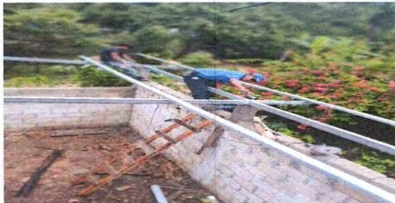
Foto 13: Sustitución de estructura de soporte de metal, por metal
