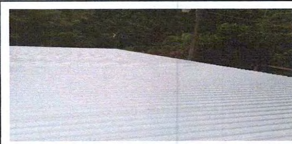
Foto 12: Sustitución de lámina, por lámina troquelada aluzinc calibre 26
