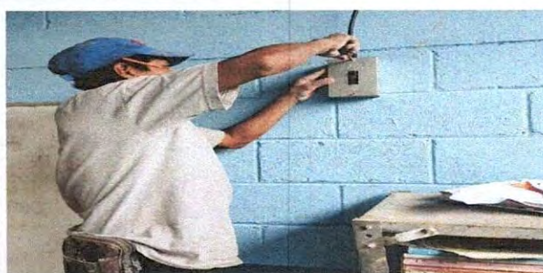
Foto 9: Sustitución de flipones
