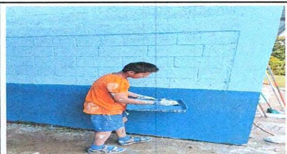
Foto 3: Pintura en muros exteriores e interiores
