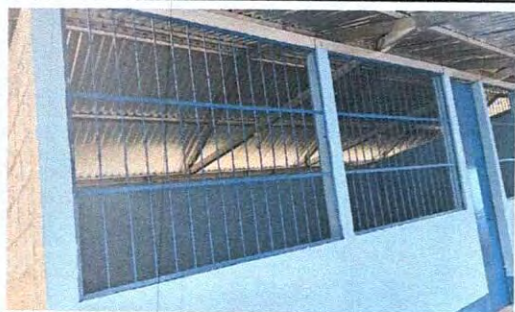
Foto 3: Fabricacion de balcones de metal
