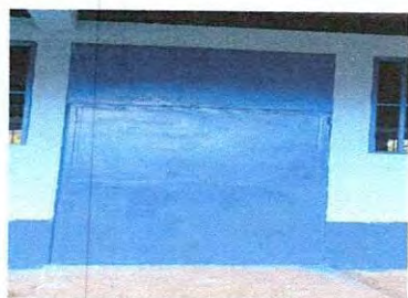
Foto 5: Sustitucion de puerta de metal
