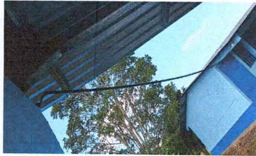
Foto 9: reparacion de cableado electrico
