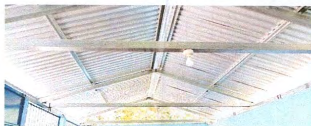
Foto 2: Sustitución de estructura de soporte de metal, por metal
