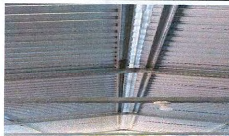
Foto 4: Institucion de sistema electrico
