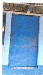
Foto 6: mantenimiento de puerta de metal
