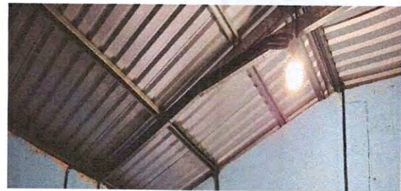
Foto 10: sustitucion de focos ahorradores
