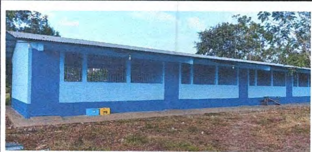
Foto 8: pinturas de muros exteriores e interiores
