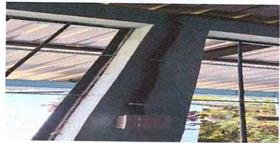
Foto 12: sustitucion de interruptores dobles
