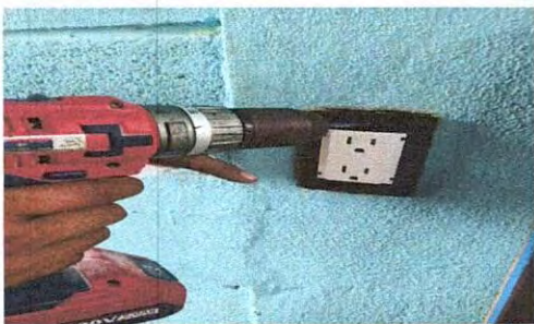
Foto 13: sustitución de toma corrientes dobles
