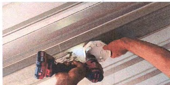
Foto 10: sustitucion de focos ahorradores
