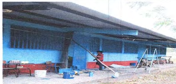
Foto 8: pinturas de muros exteriores e interiores
