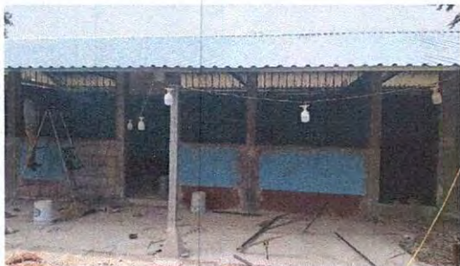
Foto 9: reparacion de cableado electrico
