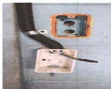
Foto 12: sustitucion de interruptores dobles
