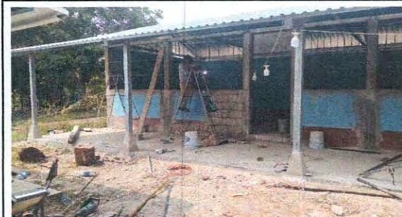
Foto 3: Fabricacion de balcones de metal
