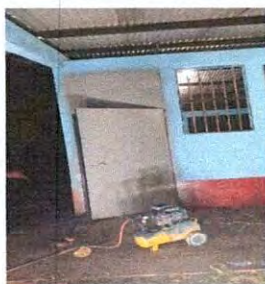
Foto 5: Instalacion de puerta de metal
