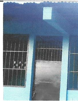
Foto 4: Mantenimiento a estructura
