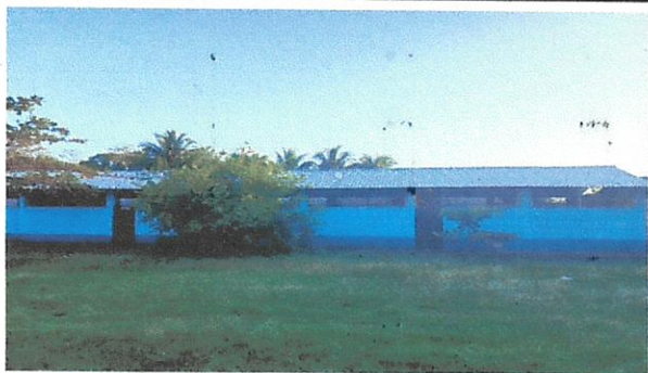
Foto1: Sustitución de lamina por lamina troquelada
