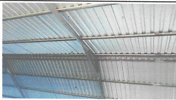
Foto 2: Sustitución de estructura de madera por metal
