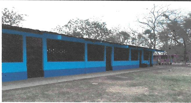
Foto 3: Pintura en muros exteriores e interiores
