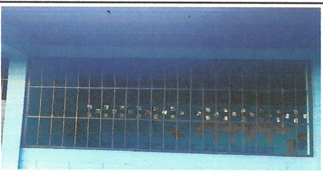
Foto 5: Mantenimiento a Balcones de Metal
