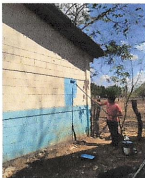
Foto 3: Pintura en muros exteriores e interiores renglón 9.1
