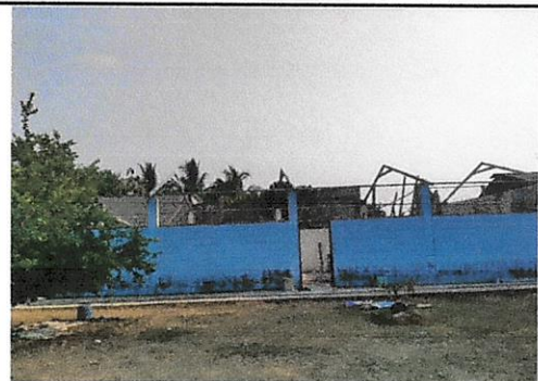
Foto 2: Sustitucion de estructura soporte de madera por metal renglón 2.2
