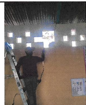
Foto 6: Sellado de grietas y fisuras en muros renglón 21.4
