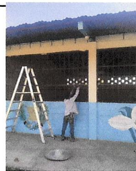
Foto 4: Mantenimiento a balcones de metal renglón 5.7
