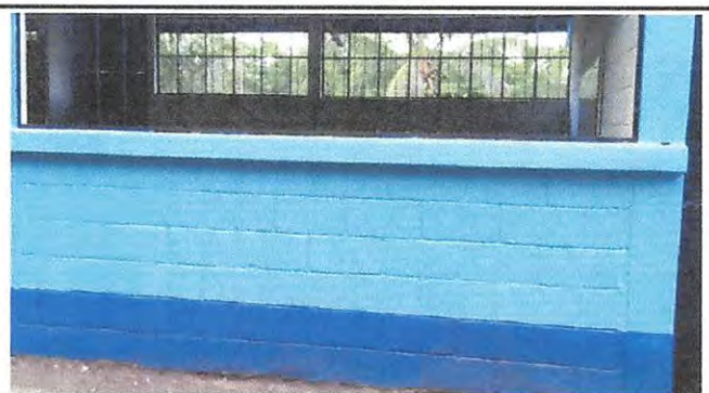
Foto 5: pintura de exteriores.
