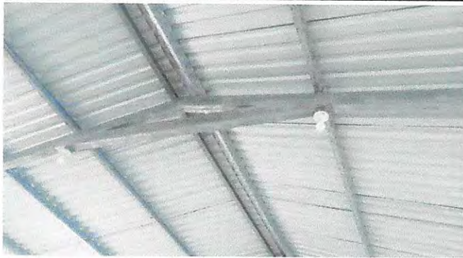
Foto 7: Reparación de cableado eléctrico.
