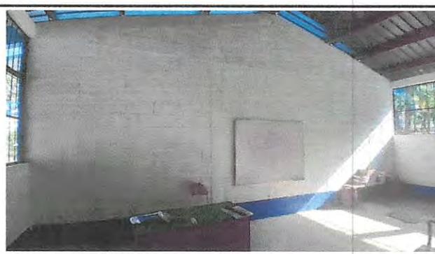
Foto 6: pintura de interiores.
