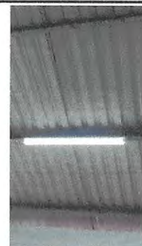
Foto 12: sustitución de lamparas tipo LED.
