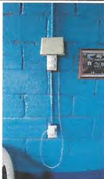
Foto 11: Sustitución de interruptores simples.
