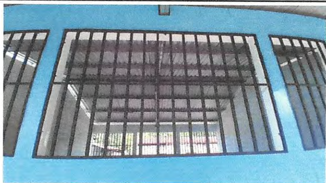
Foto 1: fabricación e instalación de balcones en ventanas.
