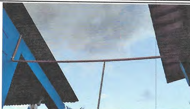
Foto 14: sustitución de ducto electrico mas accesorios.
