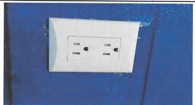
Foto 8: Sustitución de toma corriente.
