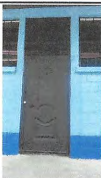
Foto 3: fabricación e instalación de puertas de metal en modulos.
