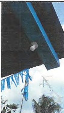
Foto 9: Sustitución de plafonera.
