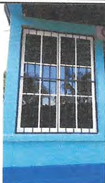
Foto 13: mantenimiento a marcos de aluminio mill finish.
