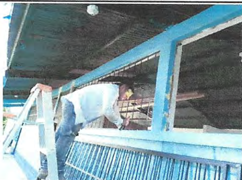
Foto 1: fabricación e instalación de balcones en ventanas.
