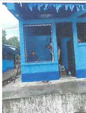
Foto 13: mantenimiento a marcos de aluminio mill finish.
