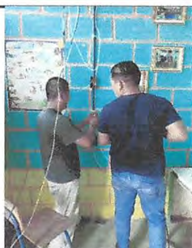
Foto 11: Sustitucion de interruptores simples.
