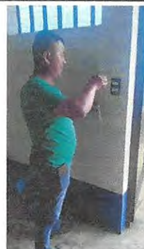
Foto 10: sustitución de interruptores dobles.
