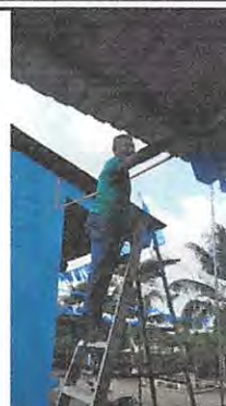
Foto 14: sustitución de ducto electrico mas accesorios.
