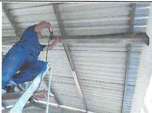
Foto 7: Reparacion de cableado electrico.
