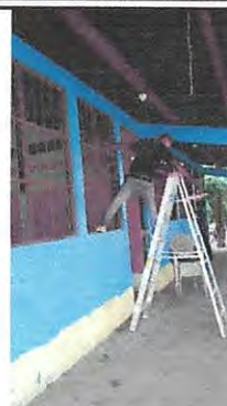
Foto 2: mantenimiento de balcones de metal.
