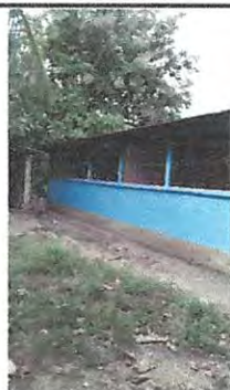
Foto 5: pintura de exteriores.
