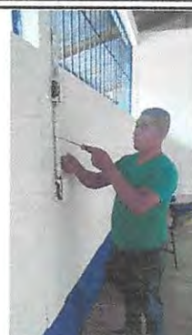
Foto 8: Sustitucion de toma corriente.
