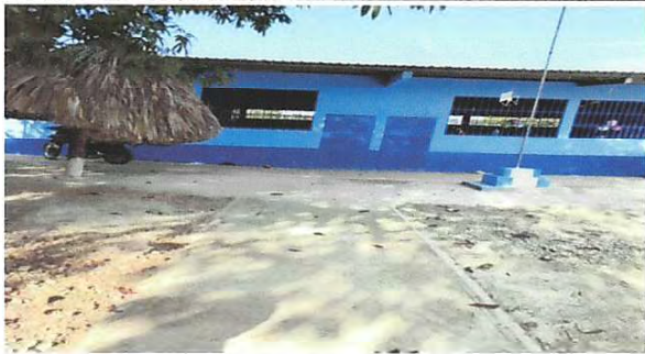
Foto1: PINTURA EN MUROS EXTERIOR E INTERIOR
