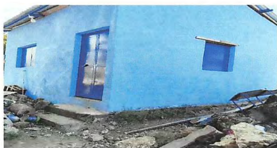
Foto 3: REPARACION DE REPELO Y CERNIDO DE PAREDES: REPELO EN MURO
