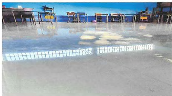
Foto1: PISOA. SUSTITUCION DE PISO CERAMICO
