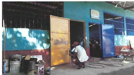
Foto 2: PUERTAS DE METAL: MANTENIMIENTO A ESTRUCTURA
