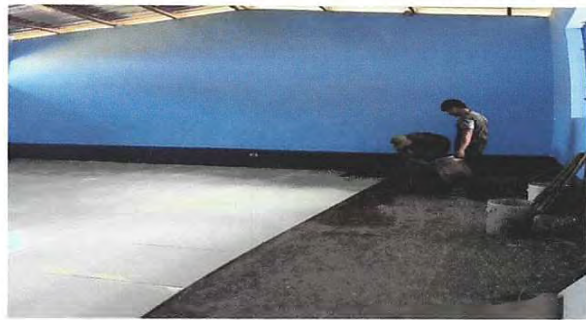
Foto1: PISOA. SUSTITUCION DE PISO CERAMICO
