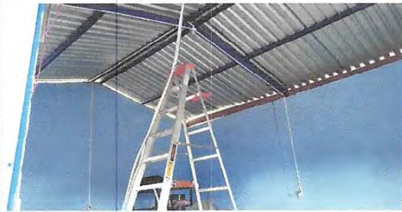
Foto 10: REPARACIÓN DEL SISTEMA ELECTRICO: SUSTITUCIÓN DE DUCTO ELECTRICO
