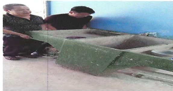
Foto 2: REPARACION DE COCINA: SUSTITUCIÓN DE PILA DE CEMENTO
