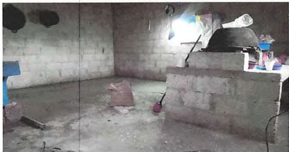
Foto 6: PISO: SUSTITUCION DE PISO DE CEMENTO LIQUIDO
