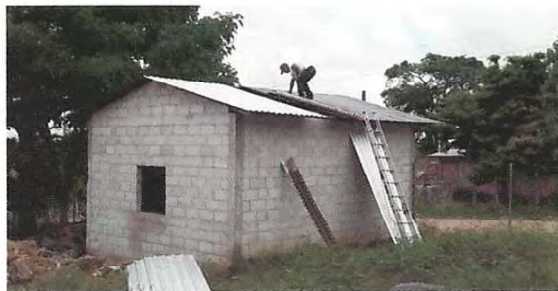
Foto 5: CUBIERTA DE LAMINA: SUSTITUCIÓN DE LAMINA POR LAMINA TROQUELADA ALUZINC CALIBRE 26
