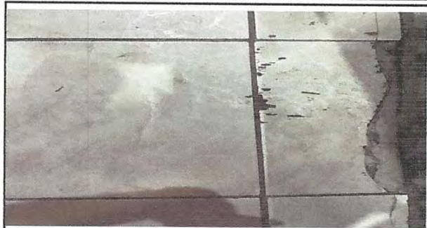
Foto1: PISO: SUSTITUCIÓN DE PISO CERAMICO
