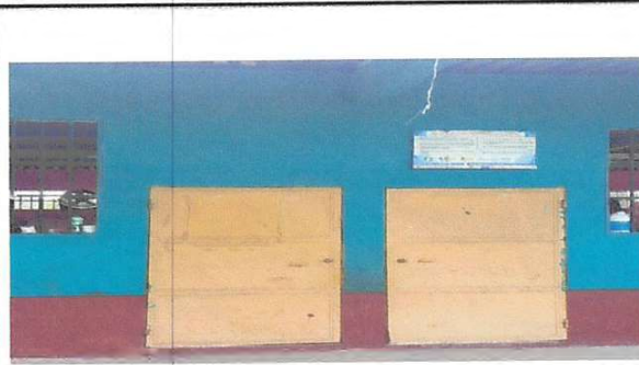
Foto 2: PUERTAS DE METAL. MANTENIMIENTO A ESTRUCTURA
