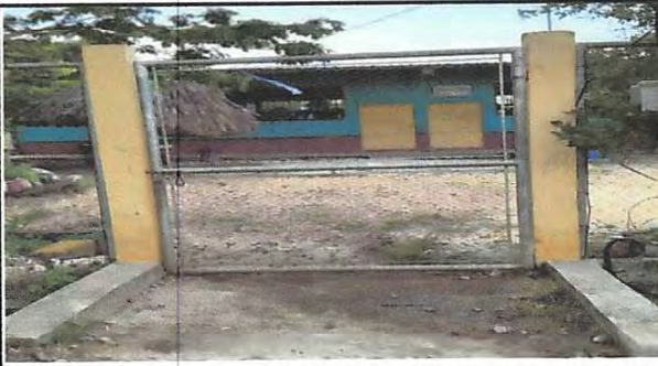
Foto 4:MANTENIMIENTO A PORTONES; MANTENIMIENTO EN PORTONES DE METAL
