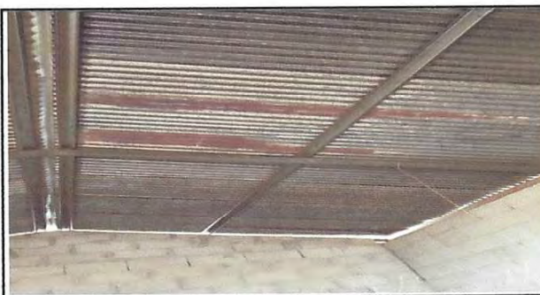
Foto 5: CUBIERTA DE LAMINA; SUSTITUCION DE LAMINA POR LAMINA TROQUELADA ALUZINC CALIBRE 26
