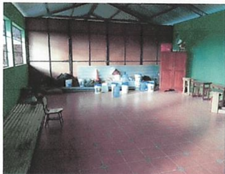
Foto1: Sustitución de Piso Cerámico
