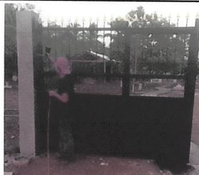
Foto 2: Fabricación e Instalación de portón de metal de ingreso
