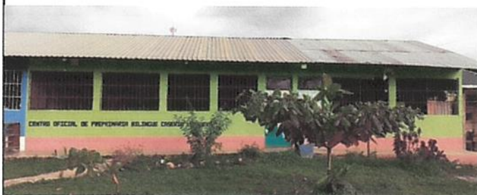
Foto 3: Pintura en Muros Exteriores
