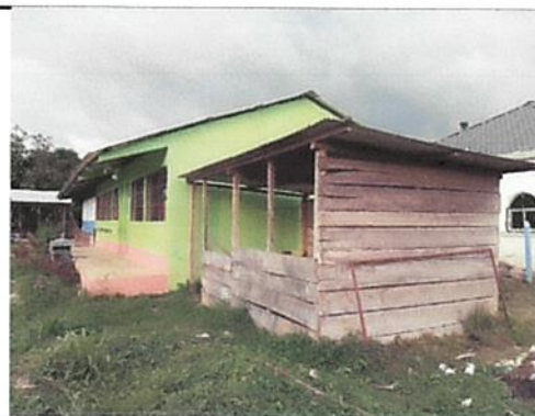
Foto 4: Alisado en Muro
