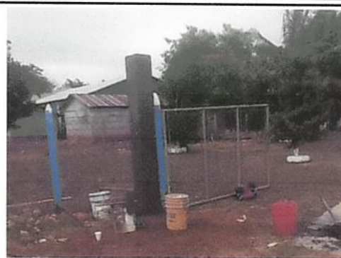
Foto 2: Fabricación e Instalación de portón de metal de ingreso
