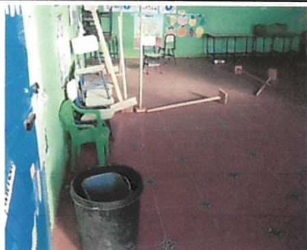
Foto1: Sustitución de Piso Cerámico
