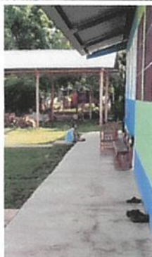
Foto 3: Pintura en Muros Exteriores
