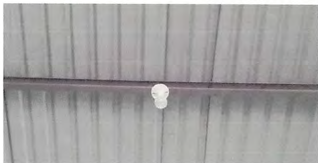
Foto 9: Sustitución De Focos Ahorrables
