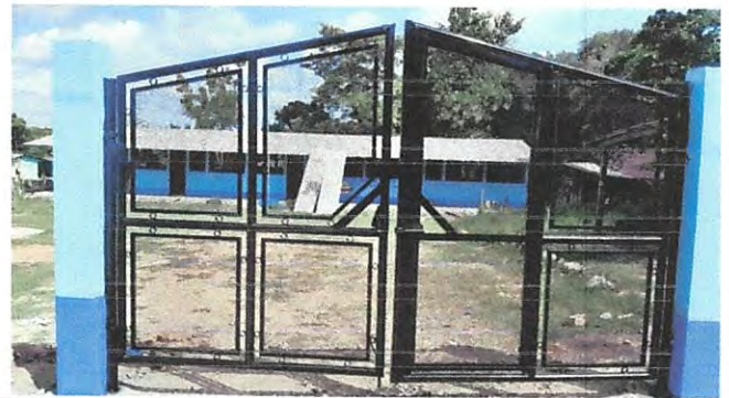
Foto 4: Sustitución de Portón de Metal
