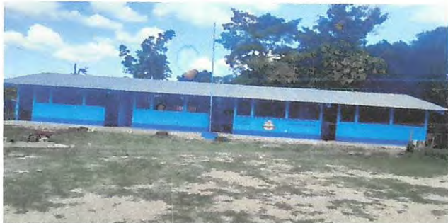
Foto 7: Pinturas en Muros Exteriores e Interior
