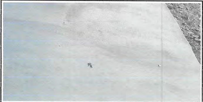
Foto 6: Reparación de piso de concreto
