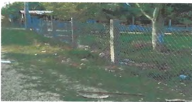
Foto 1: Sustrucion de malla.
