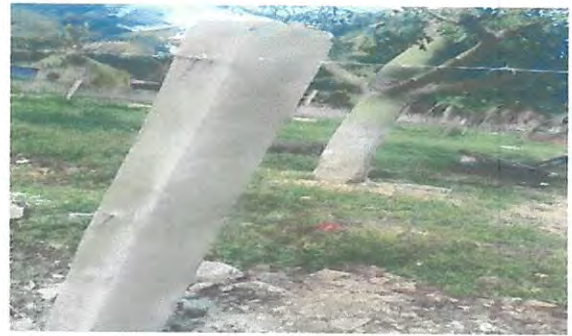
Foto 2: Sustrucion de muros de concreto.
