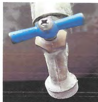
Foto 8: Sustitución De Llave De Chorro
