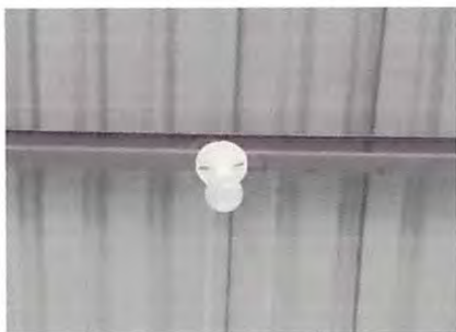
Foto 9: Sustitución de focos ahorradores
