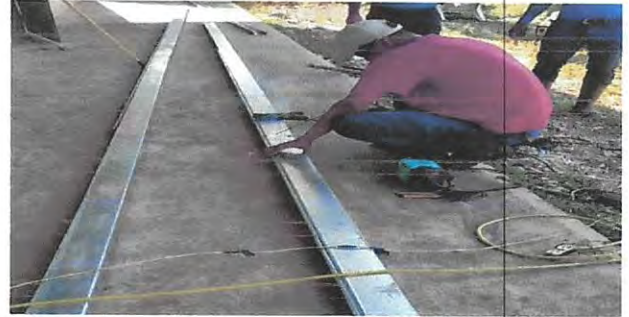
Foto 2: Sustitución de estructura de metal por metal
