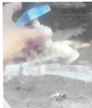
Foto 8: Sustitución de Llave de chorro
