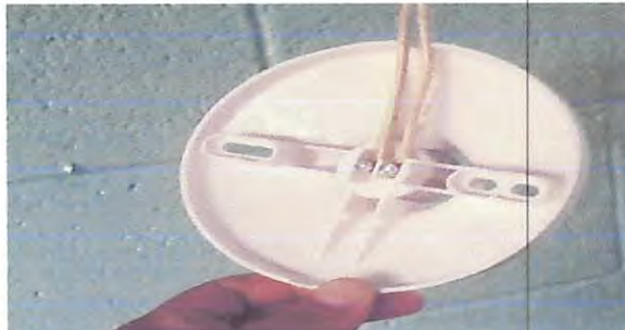
Foto 10: Sustitución de Plafoneras
