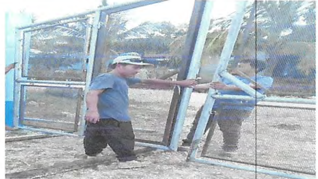
Foto 4: Sustitución de portón de metal
