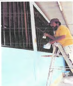
Foto7: Pinturas en muros exterior e interior
