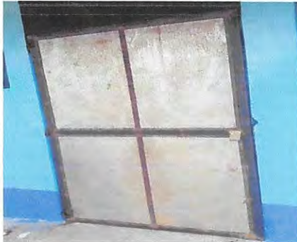
Foto 3: Sustitución de puertas
