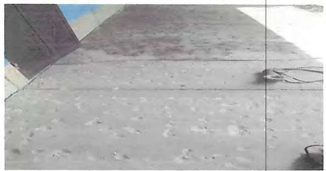
Foto 6: Reparación de piso de torta de concreto
