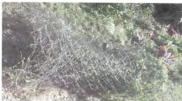
Foto 1: Sustritucion de malla.
