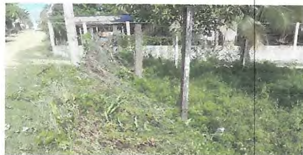
Foto 2: Sustritucion de muros.
