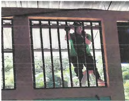
Foto 5: Mantenimiento de Balcones de metal
