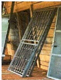
Foto 9: Elaboracion de puertas tipo balcon
