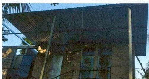
Foto 1: Sustrucción de lamina, por lamina troquelada aluzinc calibre 26 modulo de aulas modulo baños
