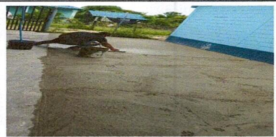
Foto 8: Sustitución de piso de torta de concreto
