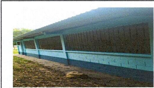
Foto 7 :Pintura en muros exteriores aulas y baños
