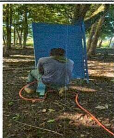
Foto 3: Mantenimiento a estructura (lijado, cambio de tubo, cepillado, sujeciones, aplicación de pintura) a puertas servicios sanitarios
