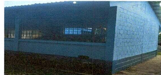
Foto 10: Mantenimiento de balcones de metal
