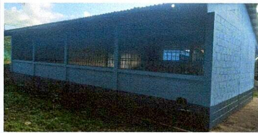
Foto 7 :Pintura en muros exteriores aulas y baños
