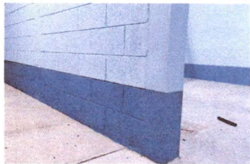
Foto 6: Pintura interior y exterior
