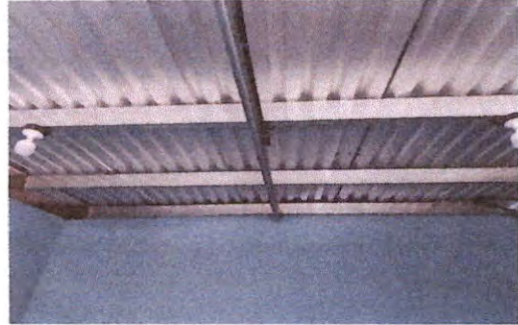
Foto 2: Sustrucción de soporte de madera por metal
