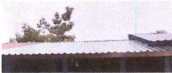
Foto 1: Sustrucción de Lámina, por lámina troquelada aluzinc calibre 26
