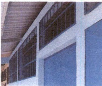
Foto 5: Sustrucción de Balcones de metal
