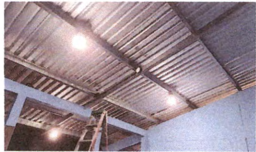
Foto 4: Instalación de sistema eléctrico
