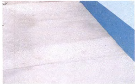
Foto 8: Reparación de piso por torta de concreto
