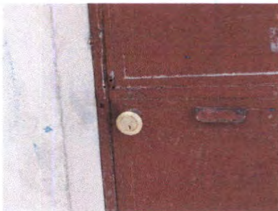
Foto 11: Sustitución de chapa
