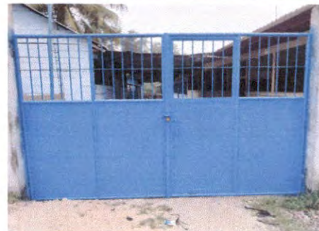
Foto 12: Mantenimiento porton de metal
