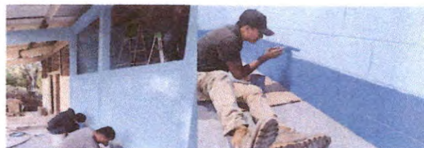
Foto 6: Pintura en muro interior y exterior
