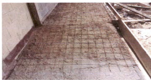
Foto 8: Reparación de piso por torta de concreto
