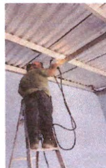
Foto 2: Sustitución de soporte de madera por metal
