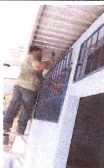
Foto 5: Reparación de Balcones de metal
