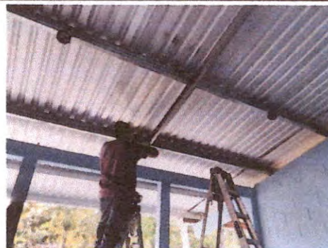
Foto 4: Instalación de sistema eléctrico
