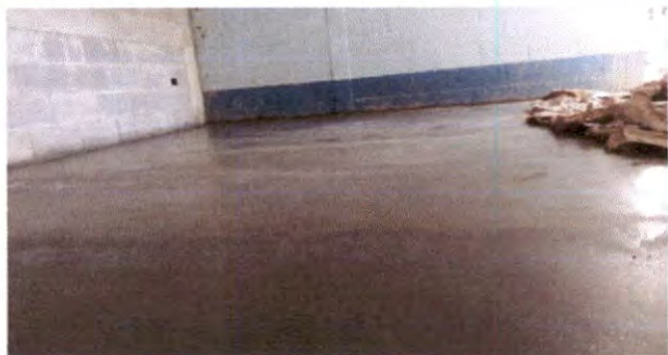
Foto 7: Reparación de piso
