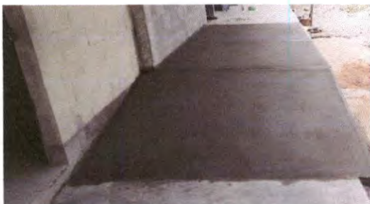
Foto 13: Sustrución de Rampa
