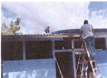
Foto1: Sustitución de Lámina
