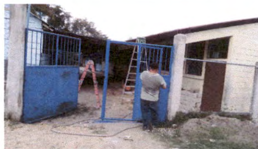
Foto 12: Mantenimiento porton de metal
