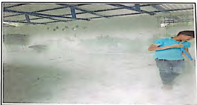
PINTURA EN MUROS INTERIOR EXTERIOR
