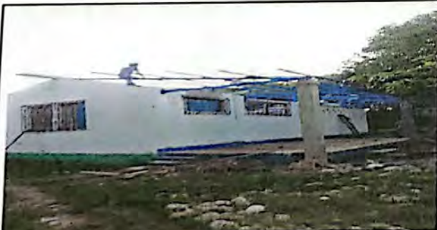
REPARACION DE ESTRUCTURA DE MADERA POR METAL
