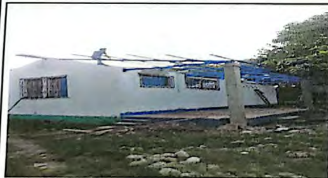
REPARACION DE ESTRUCTURA DE MADERA POR METAL
