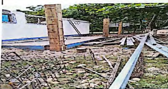
REPARACIONES DE COLUMNAS DE MADERA POR CONSTRUCCIÓN
