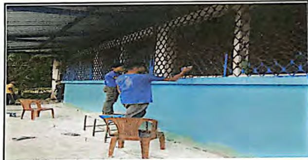
PINTURA EN MUROS INTERIOR EXTERIOR
