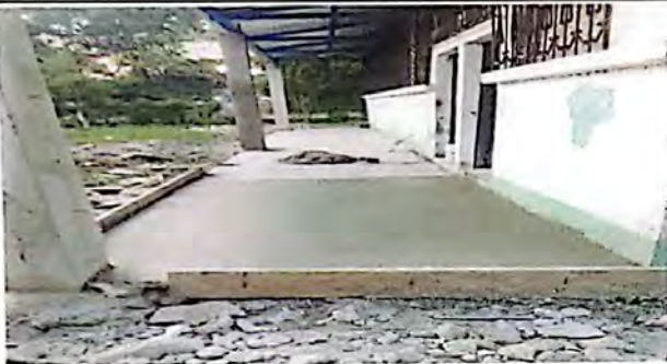
REPARACION DE PISO DE CEMENTO LIQUIDO
