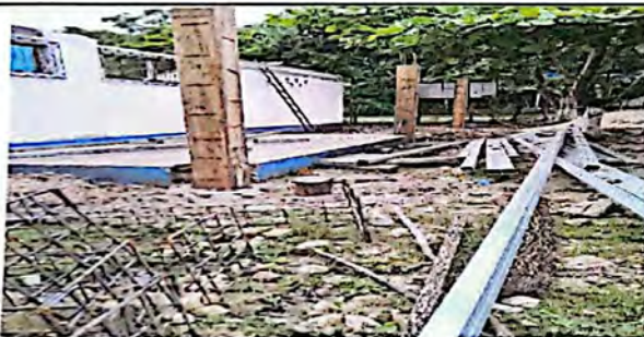
REPARACIONAS DE COLUMNAS DE MADERA POR CONSTRUCCIÓN
