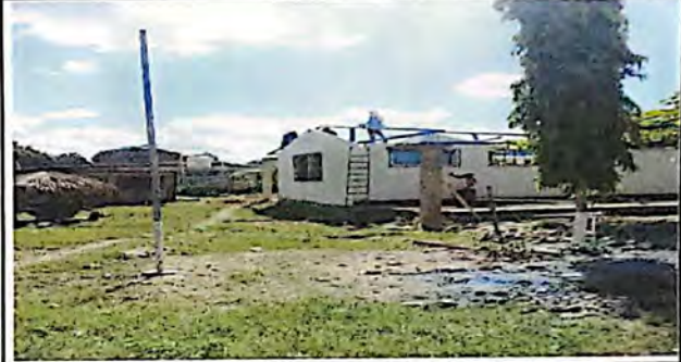
DESINSTALACIÓN DE TECHO
