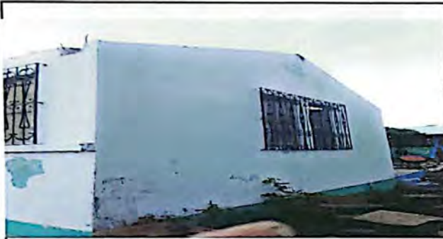
REPARACION DE PISO DE CEMENTO LIQUIDO
