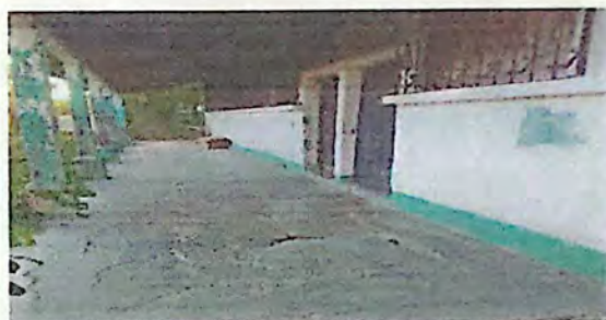
REPARACION DE PISO DE CEMENTO LIQUIDO
