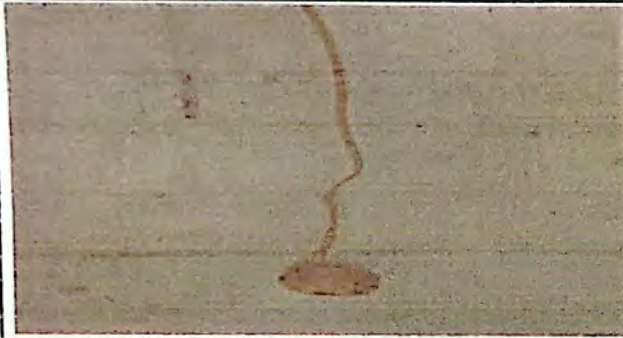
SUSTITUCIÓN DE CABLEADO ELECTRICO
