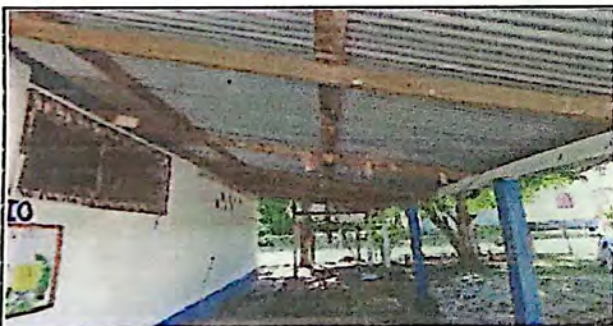
PINTURA EN MUROS EXTERIORES E INTERIORES
