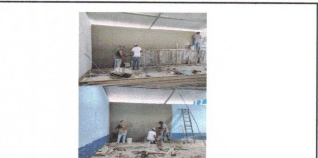
Foto 6: Sellado de grietas y fisuras en muros.
