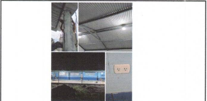
Foto 5: Reparación de Sistema Eléctrico.
