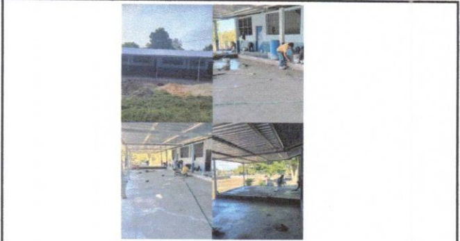
Foto 3: Reparación de piso de cemento líquido.
