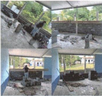
Foto 6: Sellado de grietas y fisuras en muros.
