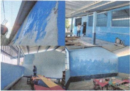
Foto 4: Pintura en muros exteriores y interiores.
