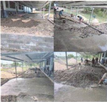
Foto 3: Reparación de piso de cemento líquido.
