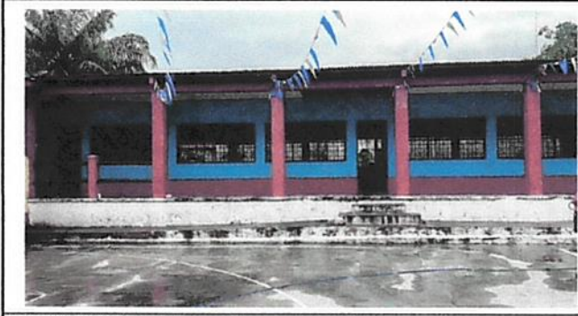
Foto 11: Pintura en muros exteriores e interiores
