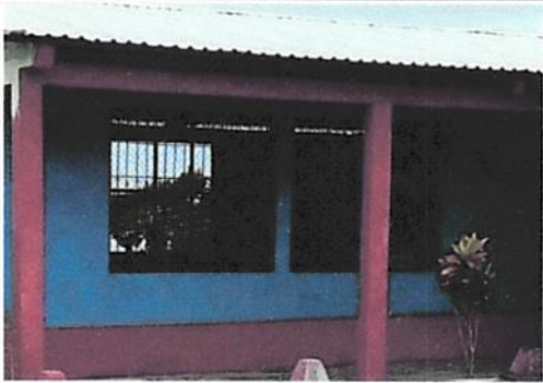
Foto 4: Sustitución de ventanas
