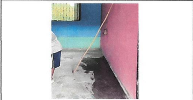
Foto7: Sustitución de piso
