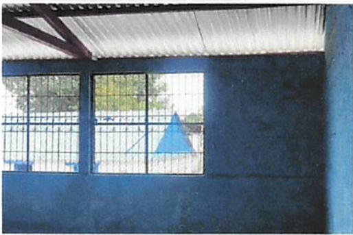
Foto 3: Sustitución de ventanas
