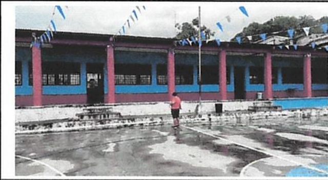
Foto 12: Pintura en muros exteriores e interiores
