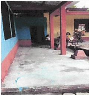
Foto 5: Sustitución de piso
