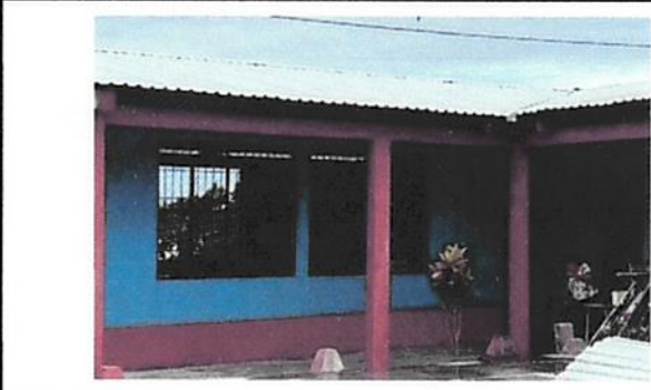
Foto 10: Pintura en muros exteriores e interiores
