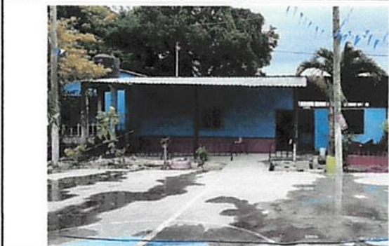
Foto 9: Pintura en muros exteriores e interiores
