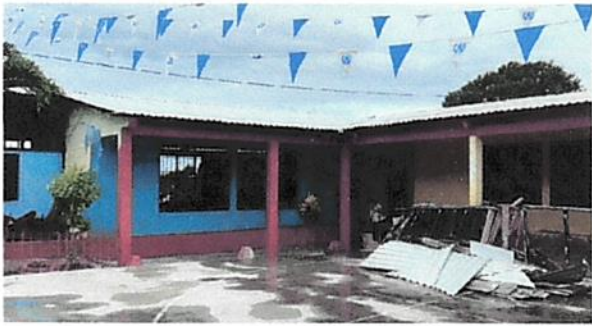
Foto1: Sustitución de laminas aulas
