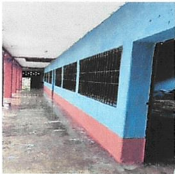
Foto 2: Sustitución de ventanas
