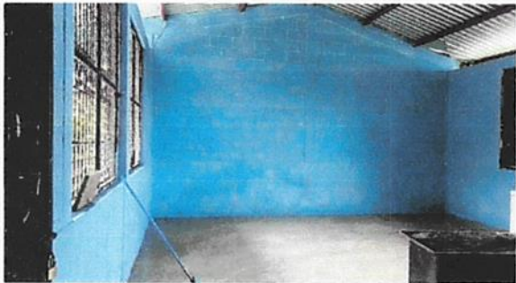
Foto 6: Sustitución de piso
