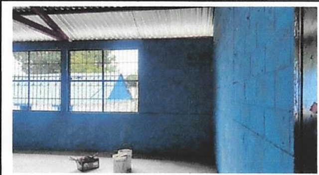
Foto 8: Sustitución de piso
