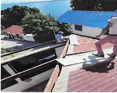
Foto 1: Sustitución de laminas aulas
