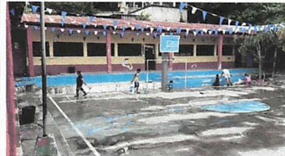
Foto 12: Pintura en muros exteriores e interiores
