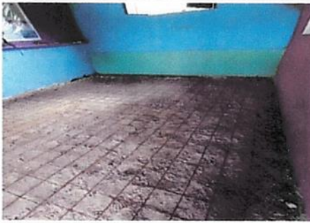
Foto7: Sustitución de piso
