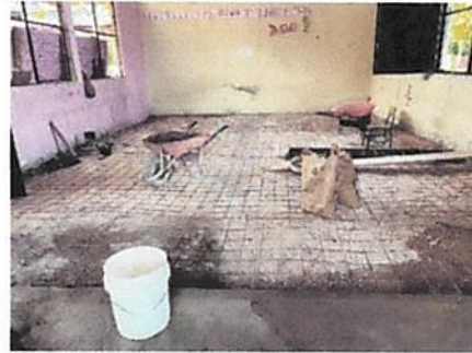
Foto 8: Sustitución de piso
