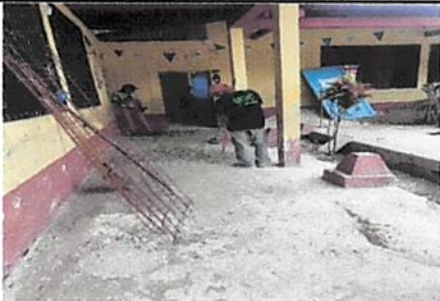
Foto 5: Sustitución de piso
