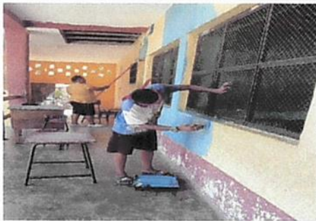
Foto 9: Pintura en muros exteriores e interiores
