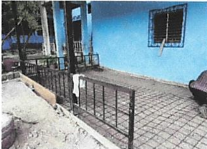
Foto 6: Sustitución de piso
