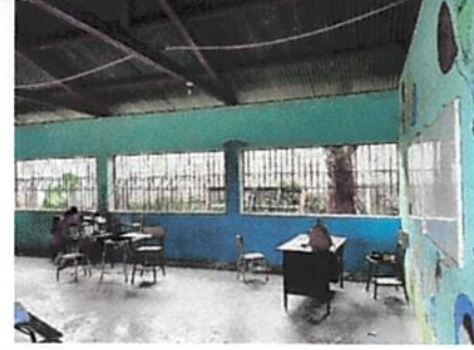
Foto 10: Pintura en muros exteriores e interiores
