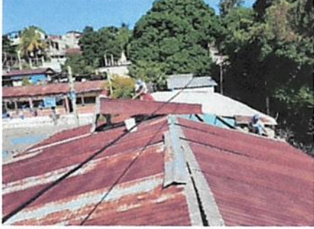
Foto 2: Sustitución de laminas de aulas
