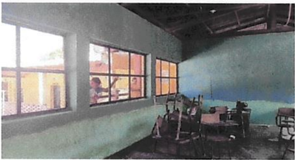
Foto 4: Sustitución de ventanas
