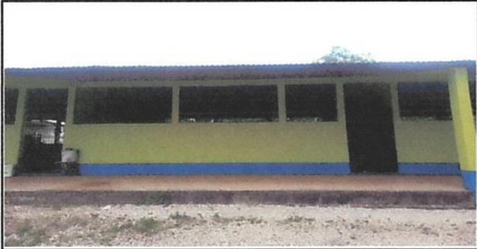
PINTURA EN MUROS EXTERIORES E INTERIORES
