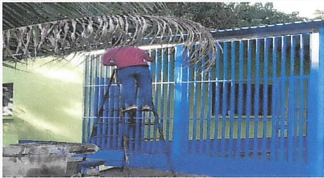
MANTENIMIENTO DE BALCONES DE METAL
