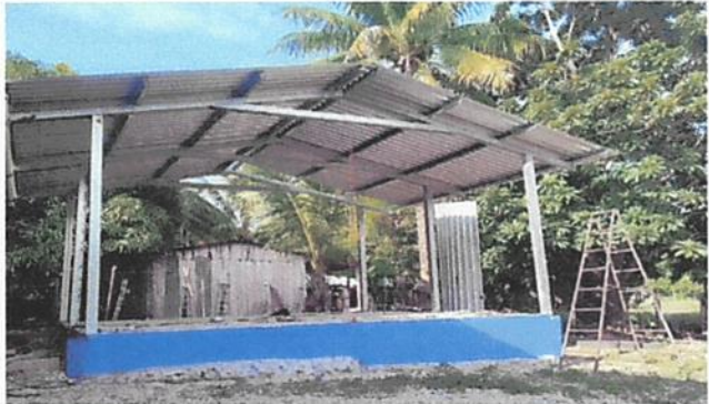
SUSTITUCION DE LAMINA, POR LAMINA TROQUELADA ALUZINC CALIBRE 26
