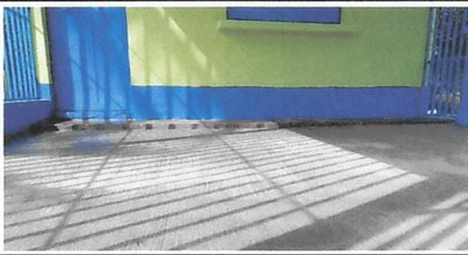
SUSTITUCION DE PISO DE CEMENTO LIQUIDO
