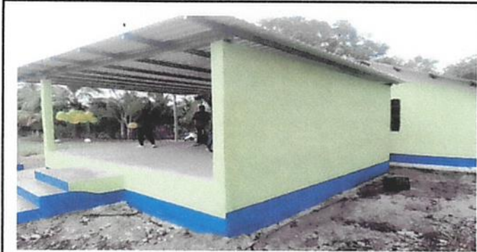
PINTURA EN MURO EXTERIOR E INTERIOR
