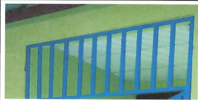
FABRICACION E INSTALACION DE BALCON DE METAL EN VENTANA
