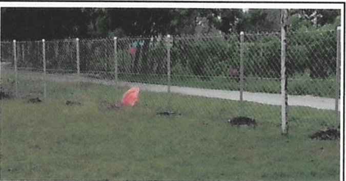
REPARACIÓN DE TUBO HG Y MALLA GALVANIZADA
