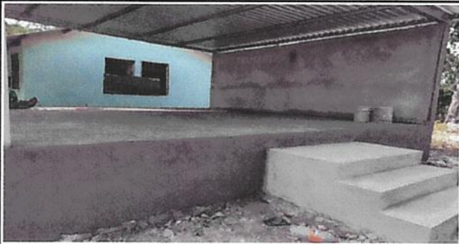
REPARACIÓN DE MURO DE CONTENCION
