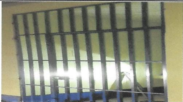
SUSTITUCIÓN DE PUERTA
