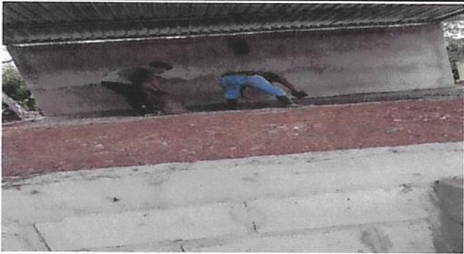
REPARACION DE MURO DE CONTENCIÓN
