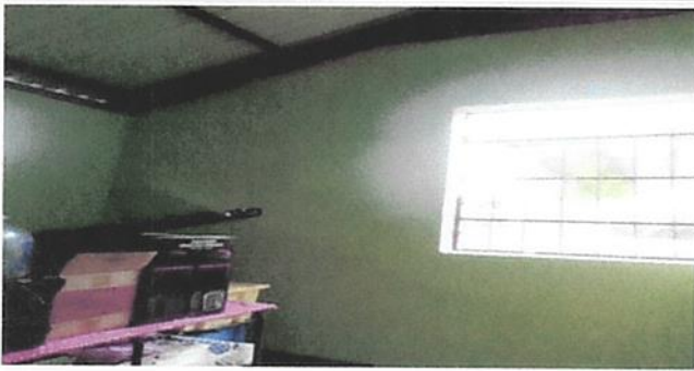
FABRICACION E INSTALACION DE BALCON DE METAL EN VENTANA
