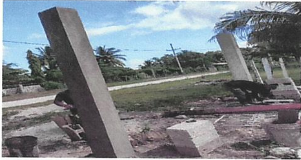
SUSTITUCIÓN DE PORTON DE METAL
