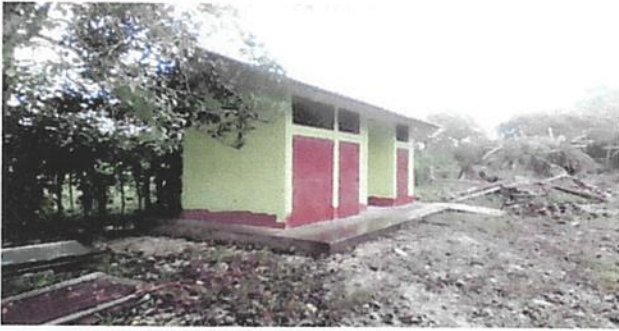
PINTURA EN MURO EXTERIOR E INTERIOR
