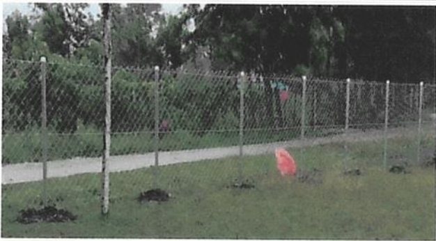
REPARACIÓN DE TUBO HG Y MALLA GALVANIZADA
