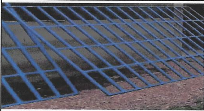
SUSTITUCIÓN DE ESTRCTURA DE SOPORTE DE METAL DE VENTANA
