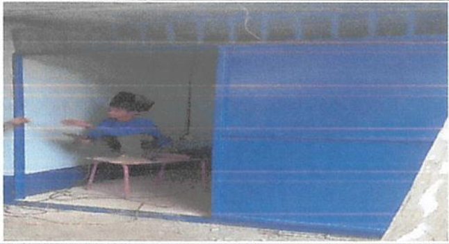
FABRICACIÓN E INSTALACION DE PUERTA
