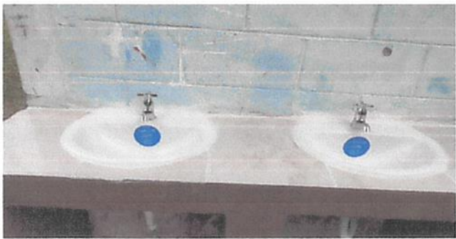
SUSTITUCIÓN DE LAVAMANOS
