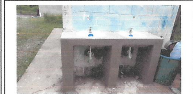
SUSTITUCIÓN DE LAVAMANOS
