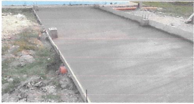
SUSTITUCION DE TORTA DE CEMENTO LIQUIDO
