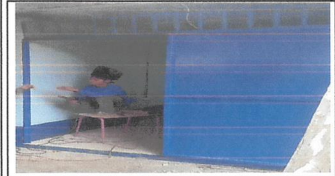
FABRICACIÓN E INSTALACION DE PUERTA
