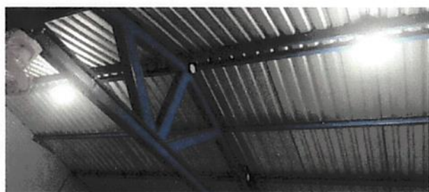
Foto 3: Cambio de la estructura metálica del techo
