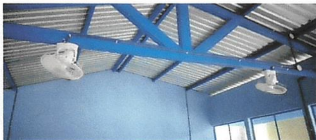
Foto1: reparacion del techado culminado
