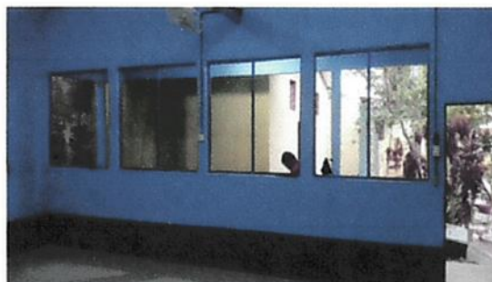
Foto 4: Pintura de la pared terminada.
