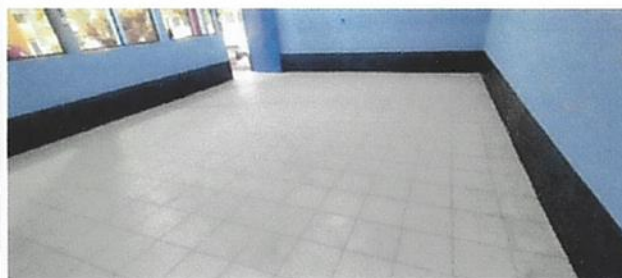
Foto 2: Reparacion del piso culminado
