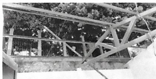
Foto 1: Reparación del techo
