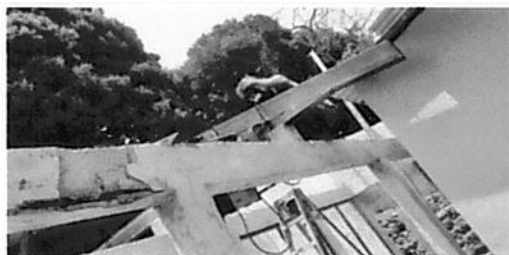
Foto 3: Cambio de la estructura metálica
