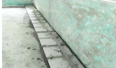
Foto 2: Reparación del Piso
