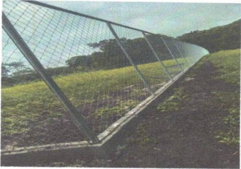
Foto1: soldadura de tubos y puesta de maila
