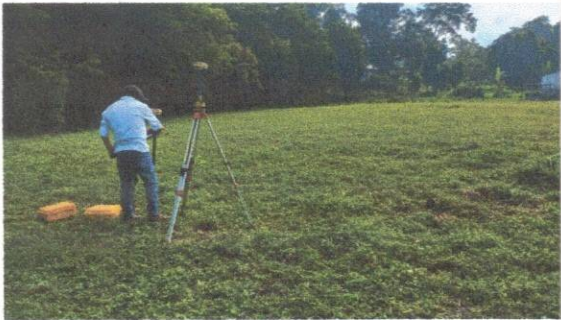
Foto1: Replanteo del area de la escuela
