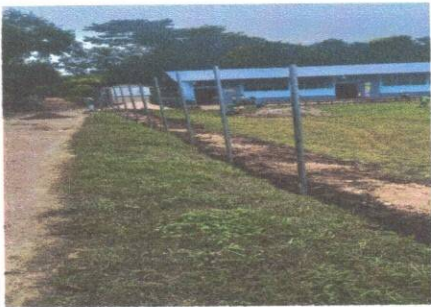
Foto 5: sangeo y puesta de tubos
